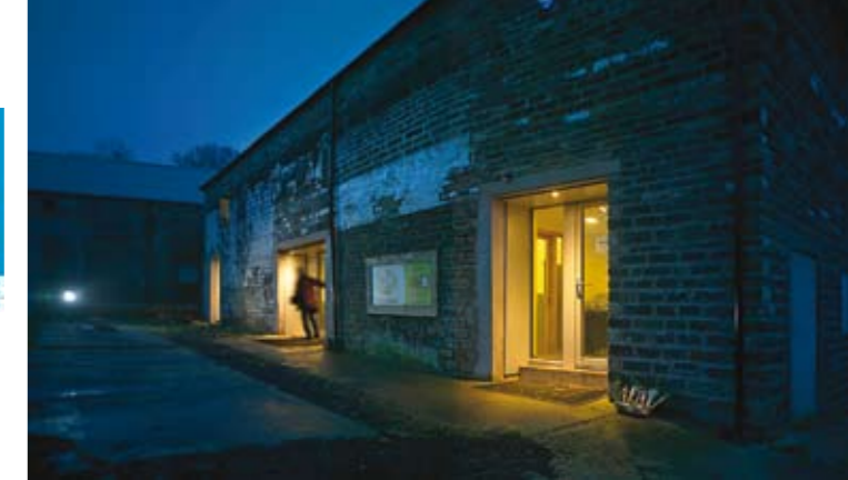
Cre8 Barn EnerPHit
